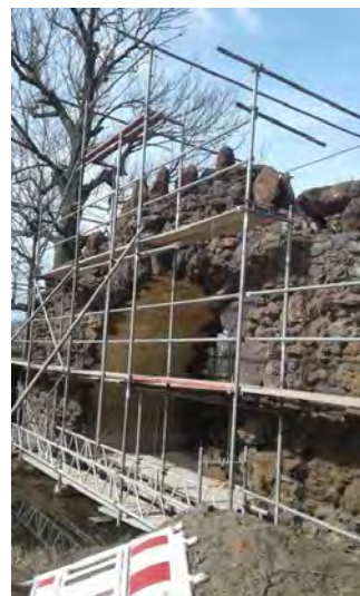
Drei Bilder von den Sanierungsarbeiten im Jahr 2018
