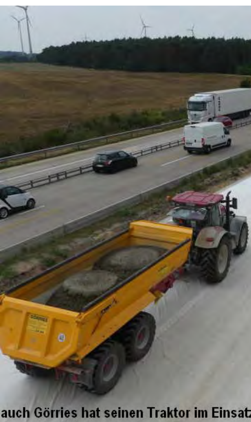
im Minutentakt werden die Muldenkipper auf der Strabag-Anlage mit Fertigbeton versorgt
